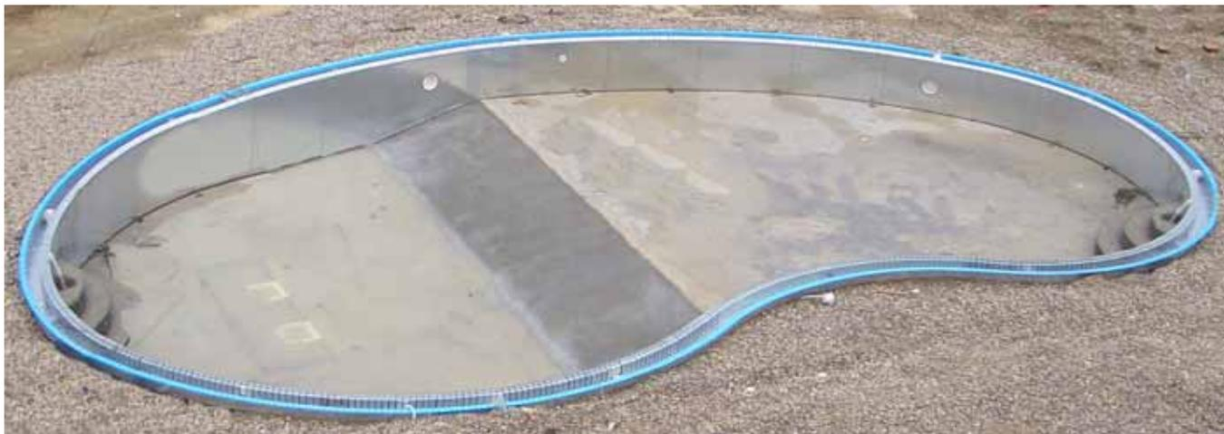
La struttura in pannelli di acciaio permette dei tempi di costruzione molto più rapidi rispetto al classico sistema in cemento armato pur mantenendo una robustezza e resistenza nel tempo quasi eguali.
